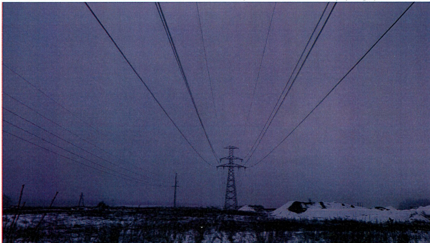
Zdjęcie nr 1. Dwutorowa Linia Wysokiego Napięcia 220 kV Adamów - Zgierz / Janów – Zgierz - przęsło nr 18 - 19.
