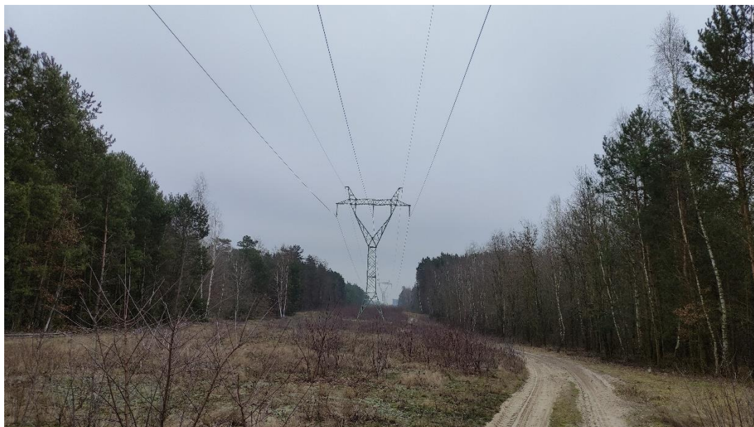
Zdjęcie nr 7. LWN 220 kV Janów – Zgierz – Adamów – widok fragmentu obiektu; prześło nr 96 – 97.
