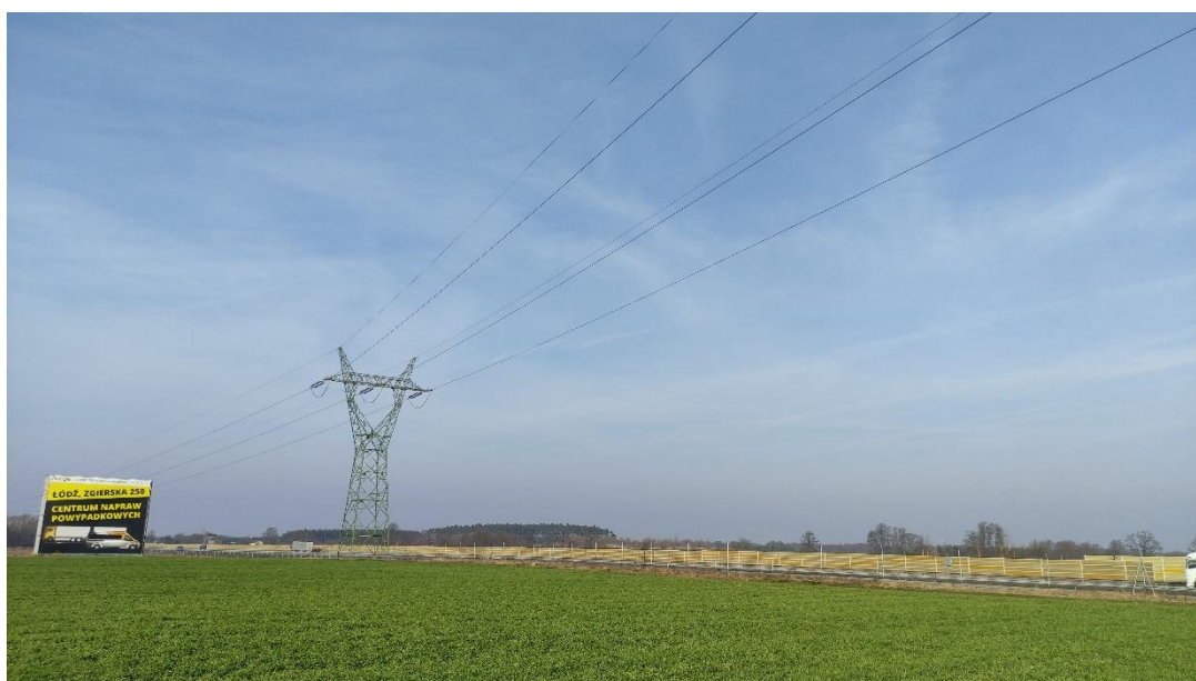
Zdjęcie nr 4. LWN 220 kV Janów – Zgierz – Adamów – widok fragmentu obiektu; przęsło nr 71A – 71.
