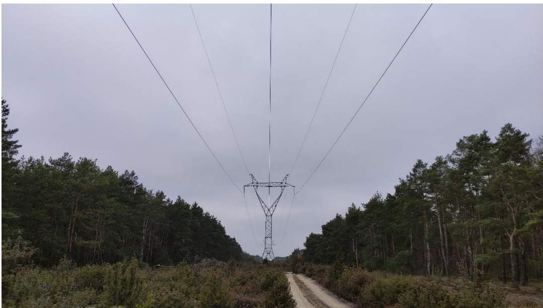
Zdjęcie nr 10. LWN 220 kV Janów – Zgierz – Adamów – widok fragmentu obiektu; przęsło nr 181 – 182.
