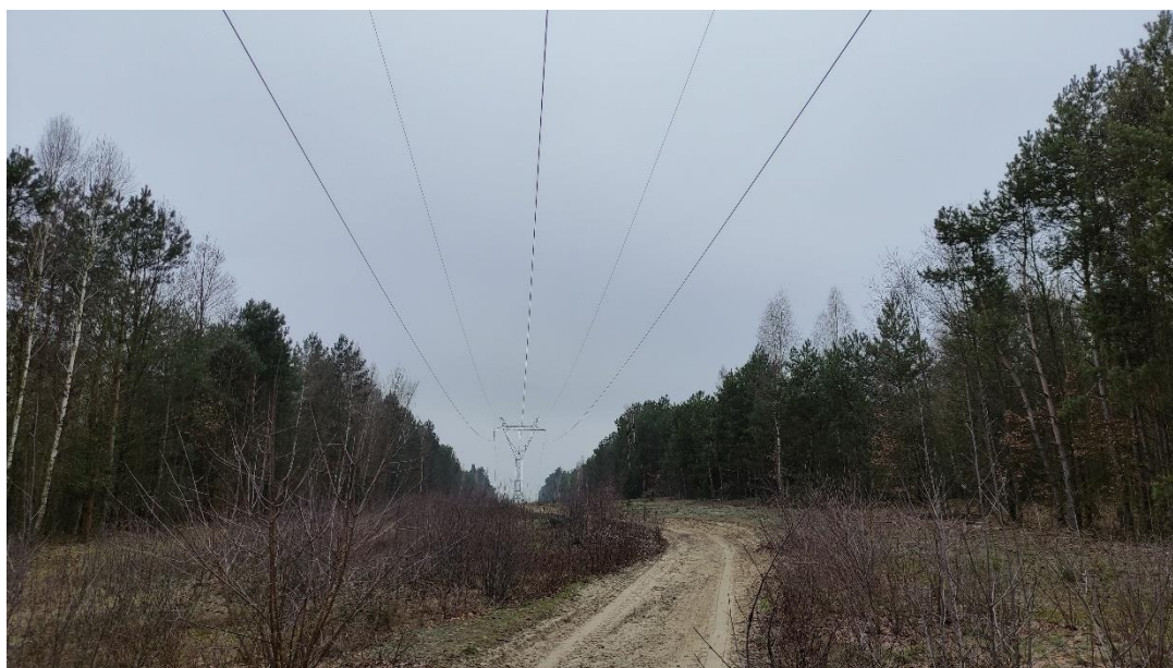
Zdjęcie nr 8. LWN 220 kV Janów – Zgierz – Adamów – widok fragmentu obiektu; prześło nr 96 – 97.
