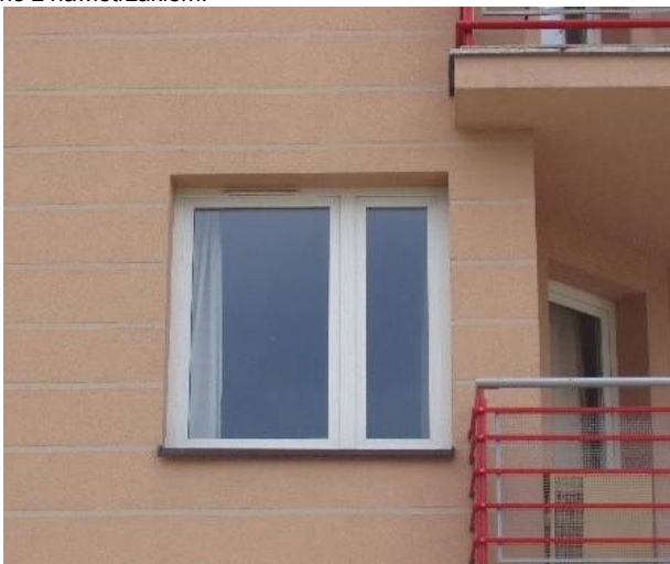
Rysunek 37. Okno dźwiękoszczelne z nawietrzakiem.
