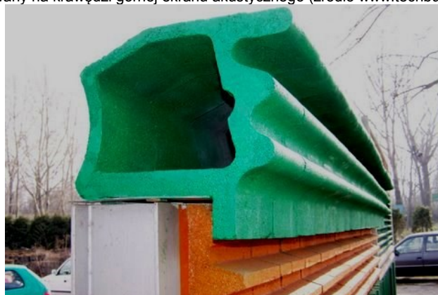
Rysunek 33. Dyfraktor zamontowany na krawędzi górnej ekranu akustycznego (źródło www.techbud.com.pl ).
