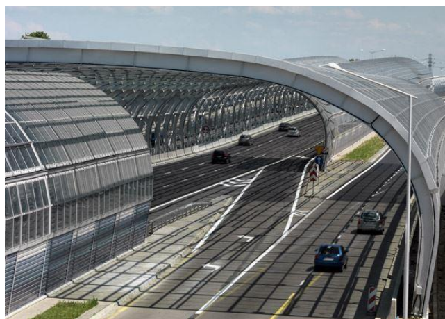
Rysunek 36. Ekran akustyczny w formie tuneli oraz półtuneli na Trasie Toruńskiej w Warszawie
