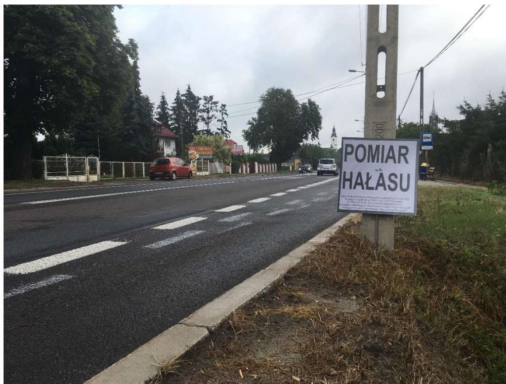
Zabudowa mieszkaniowa z usługami wzdłuż drogi krajowej nr 14
