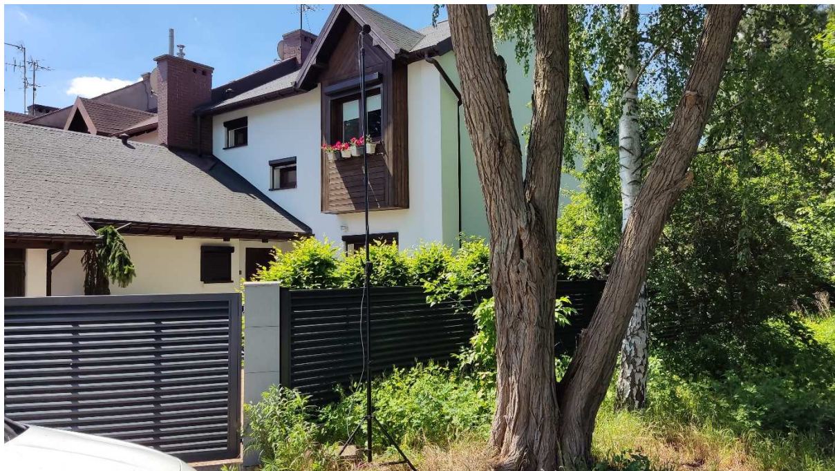
Przykładowa zabudowa na terenach zabudowy mieszkaniowej jednorodzinnej – ul. Rąbieńska
