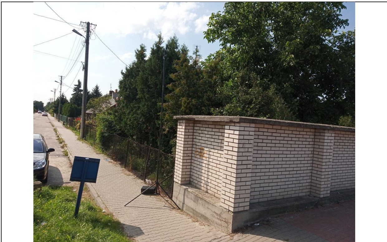
Rys. 14. ul. Jasna 29 – droga krajowa nr 70 (ul. Wyszynskiego (Wiadukt)).
