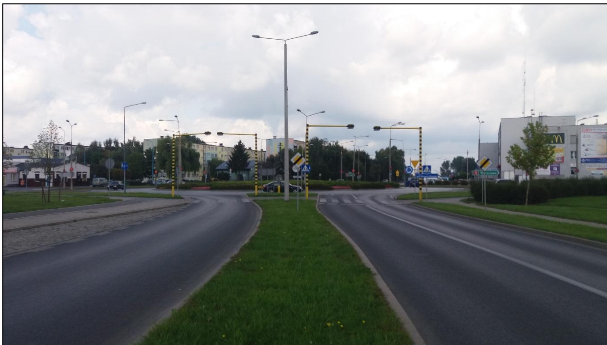
Rys. 9. Widok ronda Solidarności w ciągu Al. Pieniążka, Al. Rataja oraz ul. Mszczonowskiej.
