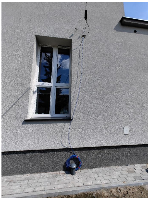
Fot 5. Wykonanie zabezpieczenia uszkodzonego kabla światłowodowego.
