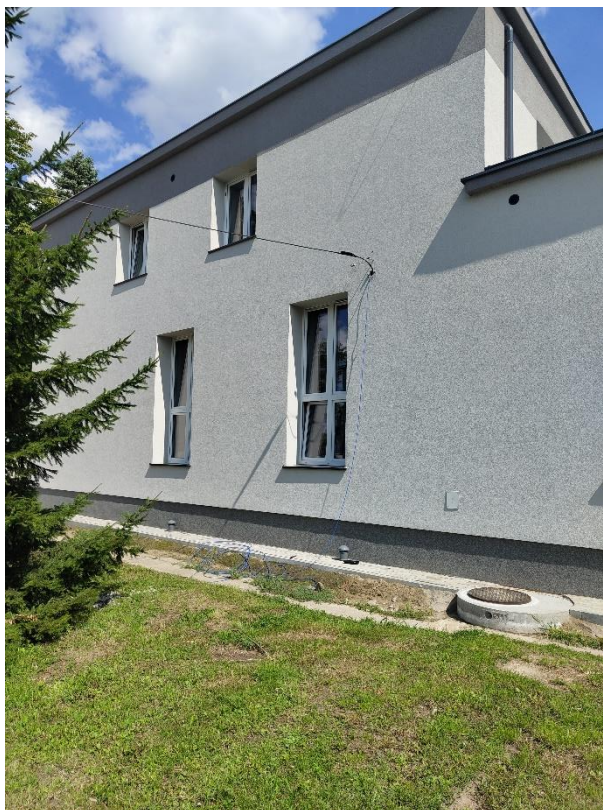
Fot 1. Uszkodzony kabel światłowodowy – budynek okulistyki.
