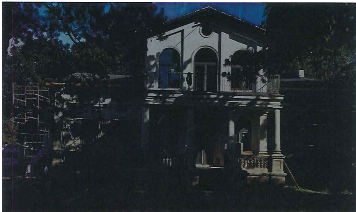
Zdjęcie przedstawia remont willi przy ul. Konstytucji 3-go Maja 36 w Tomaszowie Maz. po sprzedaży (inwestycja wykonana ze środków prywatnych).
